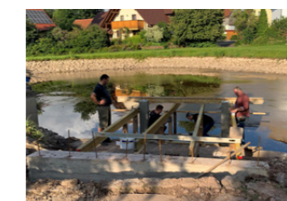
◆ Viel Eigenleistung war bei der Gründung der neuen Sonnenterrasse gefragt (Foto: Philipp Mayer)
