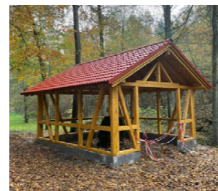
◆ Kleingradierwerk mit Überdachung
